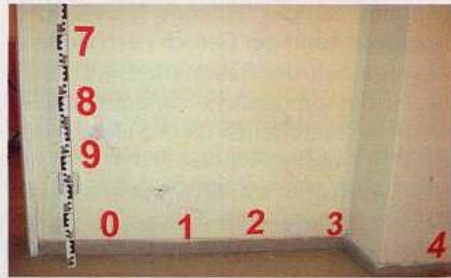
Messraster für zerstörungsfreie Feuchtemessung mit dem Mikrowellenverfahren
