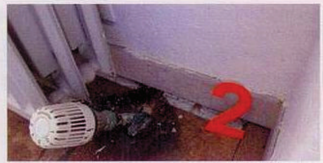
Korrodiertes Heizungsrohr
